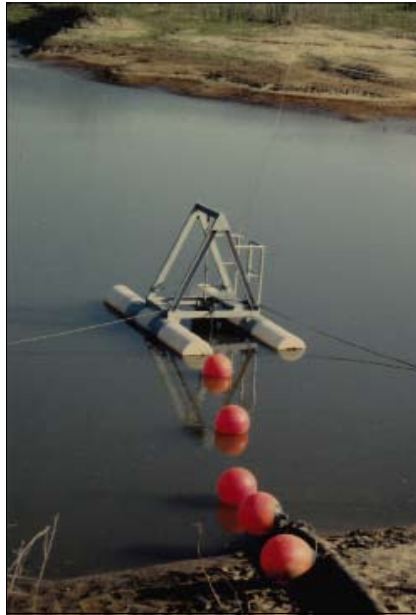
Pumpe zum Abpumpen des Grundwassers aus der Tongrube (Frühjahr 1995)
