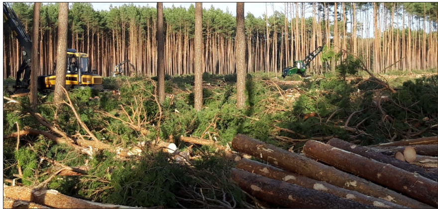
Am 13. Februar 2020 begannen die Rodungsarbeiten für die geplante Autofabrik von Tesla.
