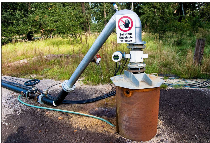
Eine Grundwasserpumpe am Tagebau
