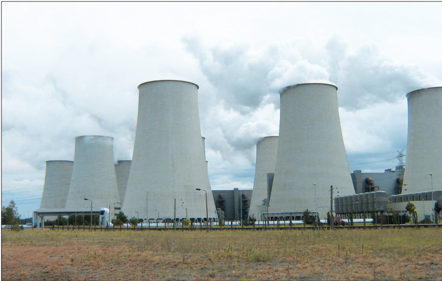
Das Kraftwerk Jämschwalde
