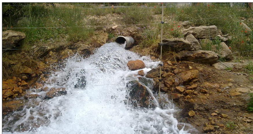
Trockenbrunnen in den Bergen, der etwa die Füllmenge eines Fußballstadions pro Jahr fördert.
