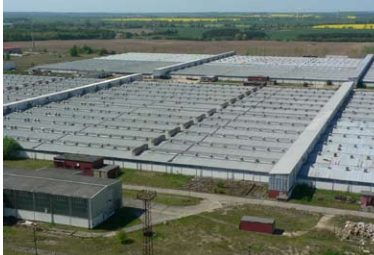
Fabrikhallen der Schweinemastanlage in Haßleben zu DDR-Zeiten Foto: DER RABE RALF
